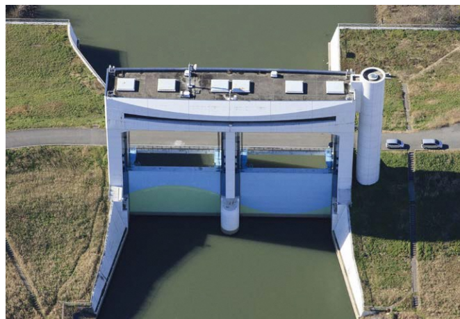
朝霞水門の写真 写真提供：国土交通省関東地方整備局
